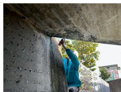
図 3. 3 錆止めの塗布
