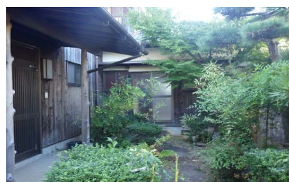
玄関付近外観
