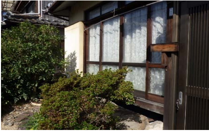
玄関付近外観
