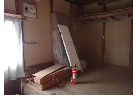
離れ1階板張り
