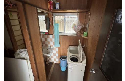
母屋 洗面及び洗濯機
