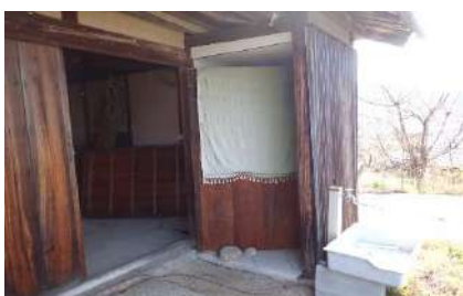
コンクリート8帖入口・トイレ入口
