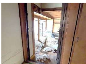
土間・トイレへの扉
