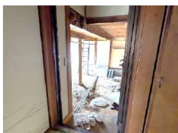
土間・トイレへの扉
