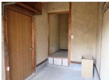
倉庫②入口
