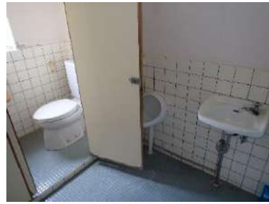
④2階 トイレ
