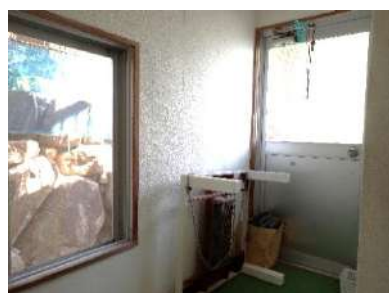
④1階 階段途中の扉
