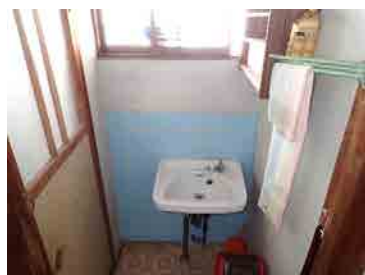
③トイレ前
