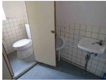
④2階 トイレ
