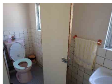
④2階 トイレ
