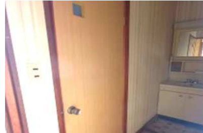
トイレドア及び洗面
