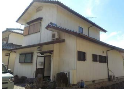
外観(ダイニングキッチン側)
