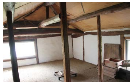
屋根裏スペース
