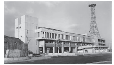
▲昭和46年竣工の現庁舎
