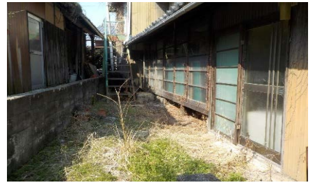
玄関周辺外観
