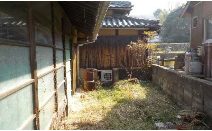
玄関周辺外観
