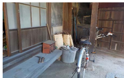
離れ入口付近
