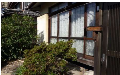
玄関付近外観
