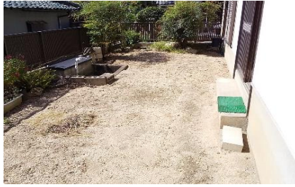
玄関付近外観
