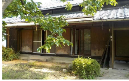
玄関付近外観
