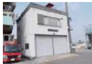
▲解体前の土庄分団消防屯所
