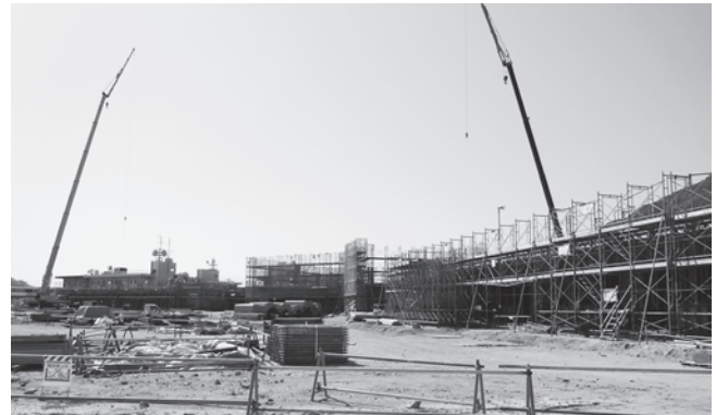
建設工事中の校舎
