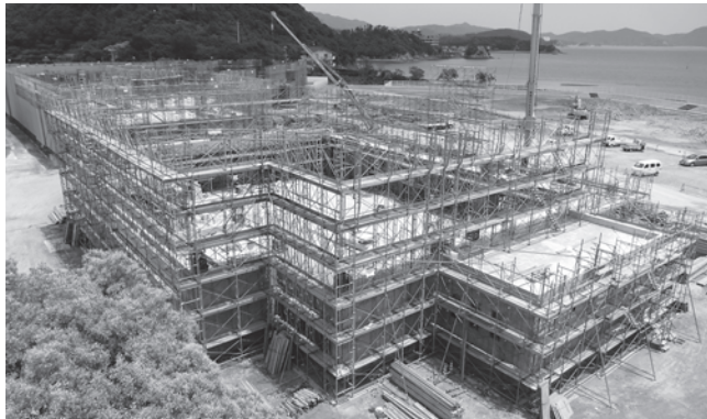
建設工事中の体育館
