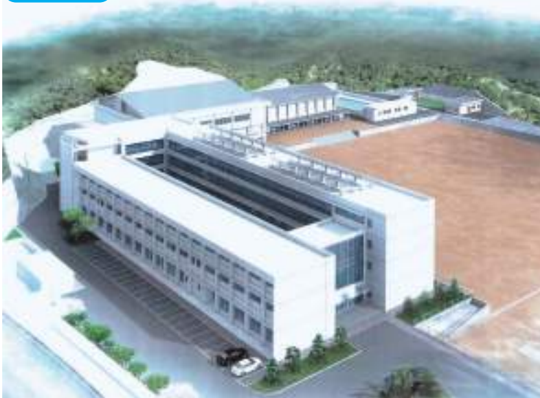
▲北西から校舎棟を望む
