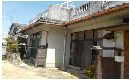
玄関付近外観
