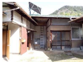
母屋・倉庫②外観
