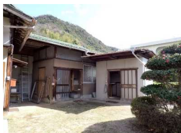
倉庫②・倉庫①外観
