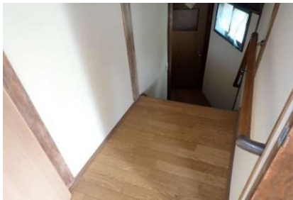
半外ボイラーへの通路
