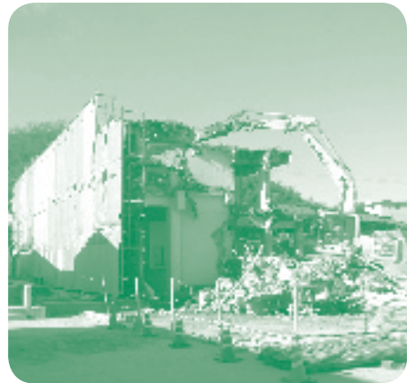
旧大部小・中学校廃校校舎解体の様子
