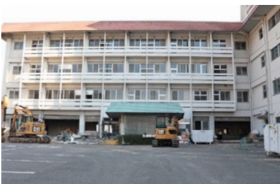
解体工事中の旧土庄中央病院
