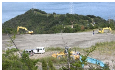
産業廃棄物を撤去している現場
