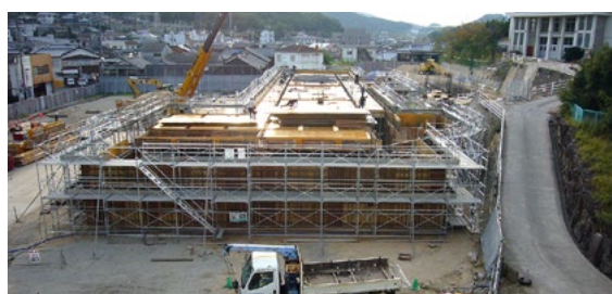
現在建設中の土庄こども園
