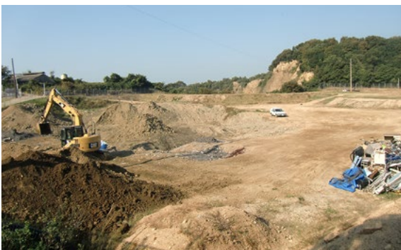
一般廃棄物処分場
