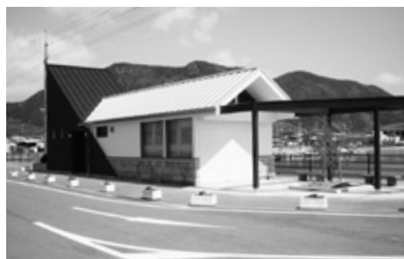
完成した公衆トイレ(左)と店舗兼案内所(右)
