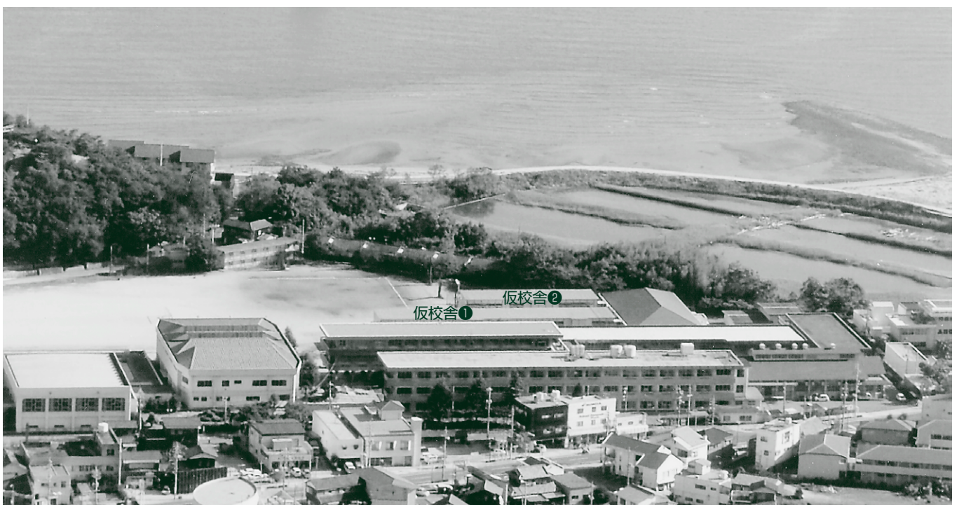
土庄中学校校舎改築工事中仮校舎（写真上部2棟）を取り囲む風景
